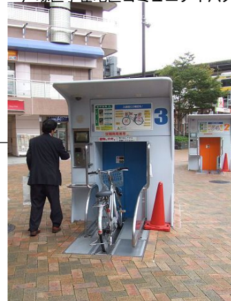
江戸川区平井駅前の地下自動式駐輪場
