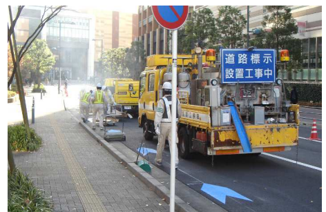
市内でも「自転車ナビライン」などの整備が進んでいます（写真は市民活動センター前）
