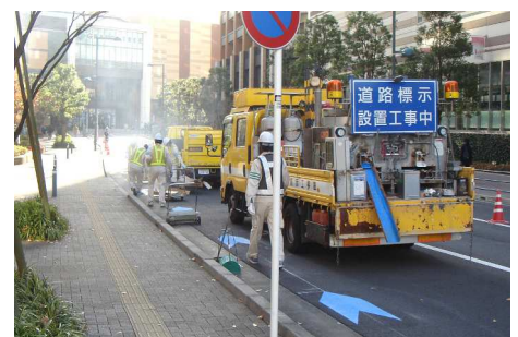
市内でも「自転車ナビライン」などの整備が進んでいます（写真は市民活動センター前）
